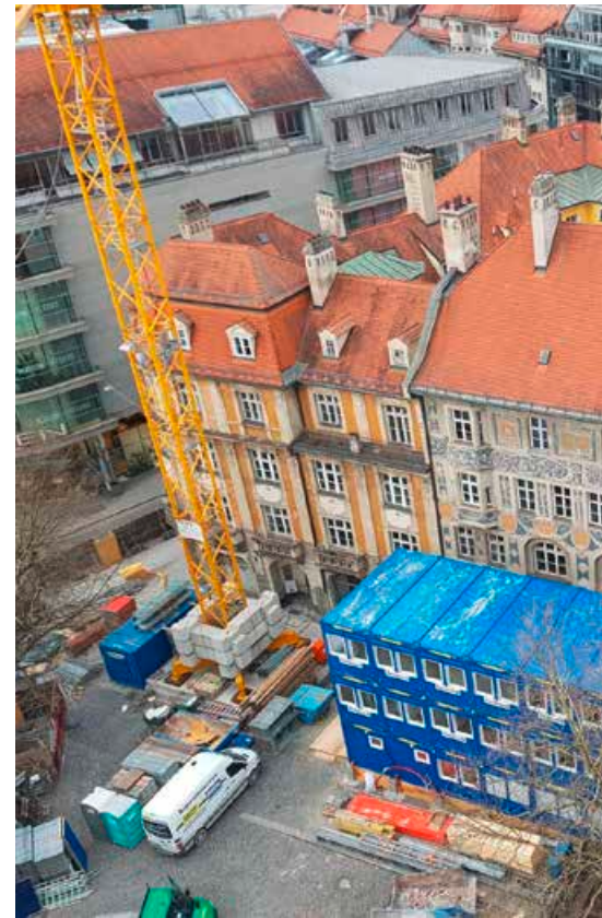
Blick auf das Ruffinihaus vor der Aufstellung des Bagerüsts
