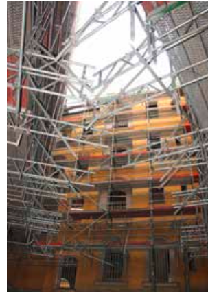
Links: Blick auf den Zustand des Bauwerks vor der Sanierung
