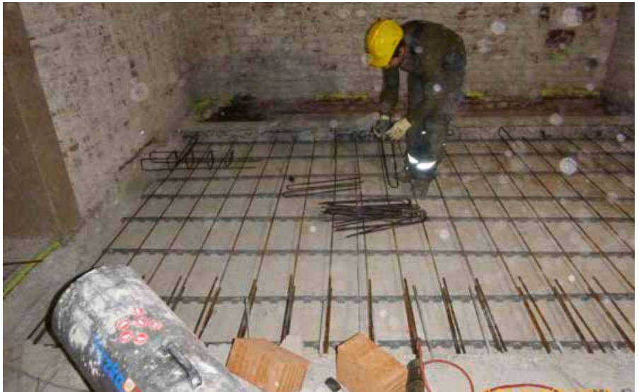
21 einzelne Heizgeräte sorgten während der kalten Wintermonate genau dort für Wärme, wo sie benötigt wurde.
