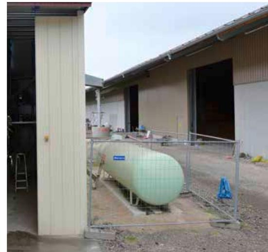
**Diese Interimsanlage stellte Tycza während des Testbetriebs bis zur Installation des 32 Kubikmeter fassenden Flüssiggastanks zur Verfügung.**
